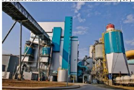
b) elektrownia zawodowa zasilana biomasą [13]
